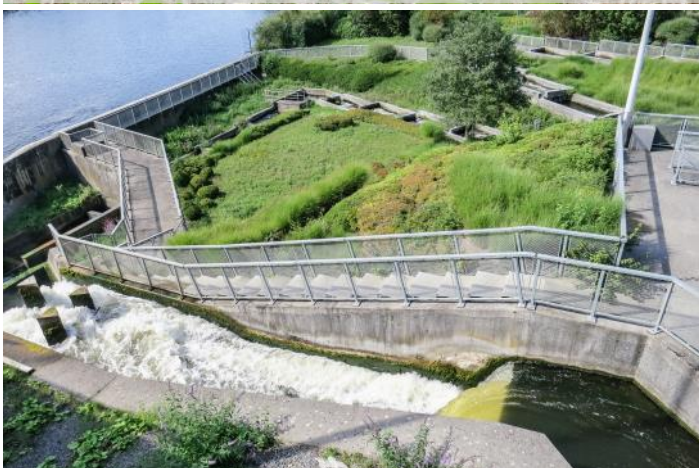
Echelle à poissons, au barrage de Lixhe Dominique Ludwig
