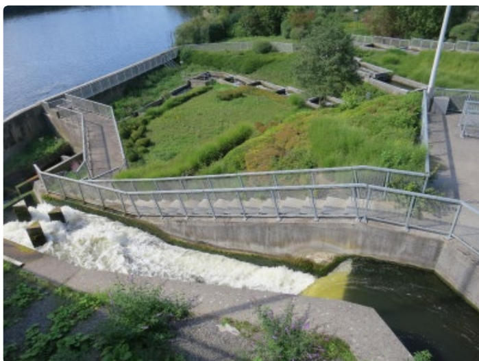
- Echelle à poissons au barrage de Lixhe -
